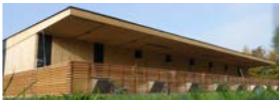
Abbildung 1: Abferkelstall aus Holz
