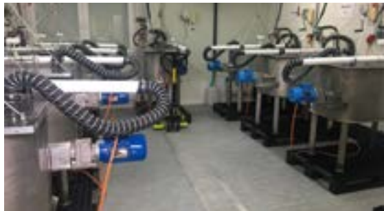
Abbildung 2: Gesamte Anlage (9 Behälter) im klimatisierten Containerkomplex, es können zeitgleich mehrere Wiederholungen an Rohgülle und Gülle mit Zuschlagstoff bemessen werden (Zentner A., 2020)
